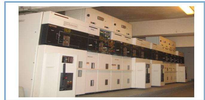
MV Switchgear
